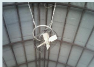
乾乳用D型牛舎に首振りファンを設置
