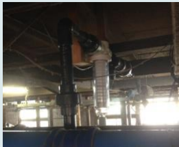
電磁弁（電気をオン、オフにすることにより、水の流れを止めたり、流したりするもの）
