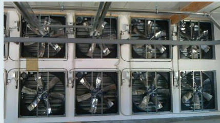
岩手の新築牛舎のトンネル換気のファン
