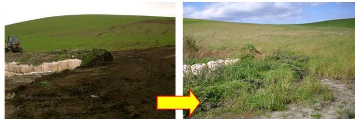
堆肥と黒ボクを混和してガリを埋め鎮圧。フレコンの土嚢(どろ)で補強。
