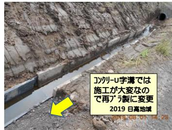
コンクリートU字溝では施工が大変なので再生プラスチック製に変更
