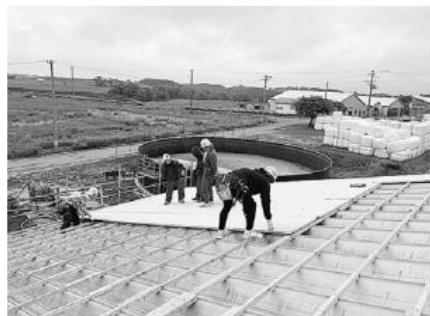
断熱パネルの設置の様子
